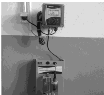
Rys.3. Sposób montażu analizatora i przetwornika pomiarowego
