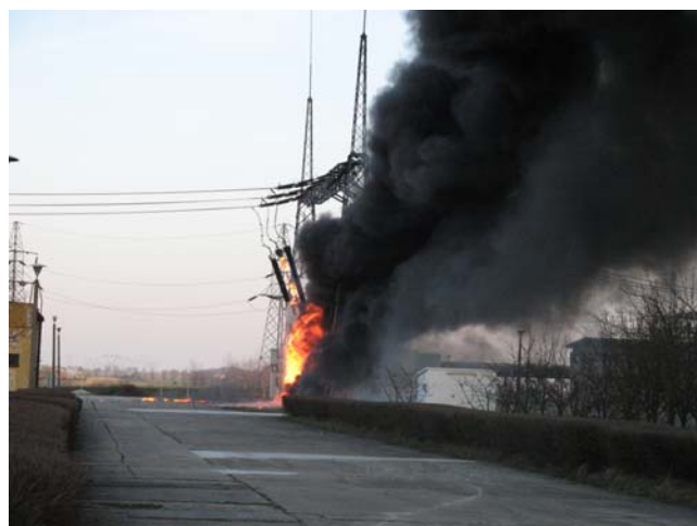
Rys. 3. Pożar transformatora w wyniku eksplozji przepustu izolatorowego strony 400 kV
