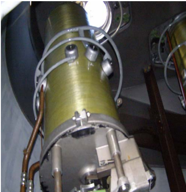
Rys. 6. Przemieszczony w wyniku awarii podobciążeniowy przełącznik zaczełów autotransformatora o mocy 500 MVA
