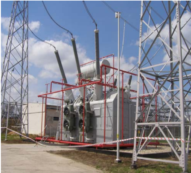
Rys. 5. Transformator z kompozytowymi (suchymi) przepustami izolatorowymi strony 400 kV
