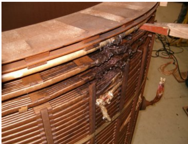
Rys. 1. Zwarcie zwojowe w cewce GN 220 kV transformatora blokowego
