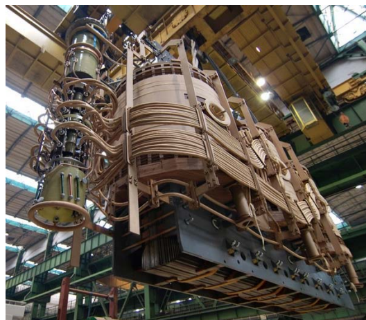
Rys. 4 Część aktywna transformatora blokowego TOBNRLa 290000/400
