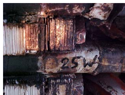
Rys.3. Widok uszkodzonych zębów pakietów skrajnych rdzenia stojana TWW-200-2A
