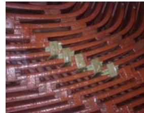
Rys.5. Naprawa i dosztynienie części ewolwentowej
