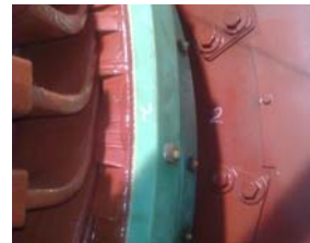
Rys.7. Dosztynienie pierścieni wsporczych generatora
