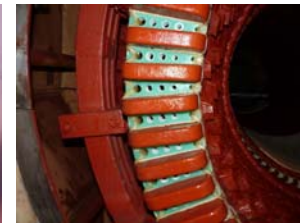
Rys.8. Usztynwienie końca uzwojeń wraz z pokrywami izolacyjnymi
