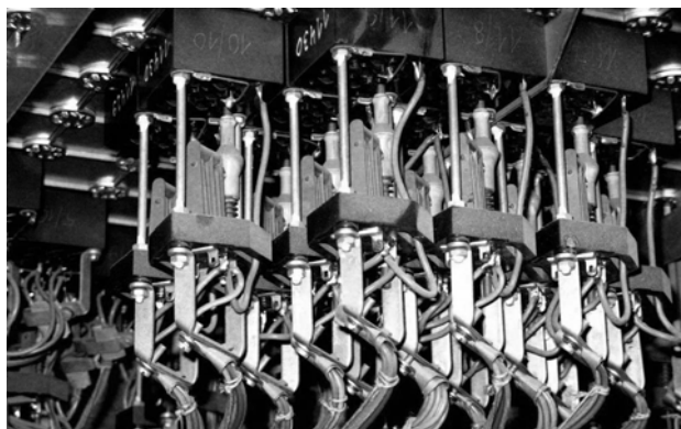
Rys.3. Spód kratownicy z elementami przełącznymi i oprawkami
