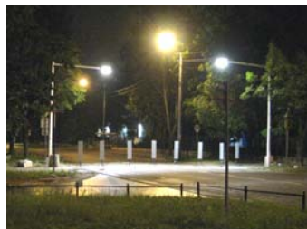
Rys. 8. Widok oświetlonego przejścia dla pieszych oprawami dodatkowymi typu 2
