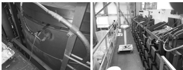
Rys.5. Pomiary na części aktywnej
