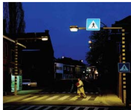
Rys.5. Oświetlenie przejścia dla pieszych [7]
