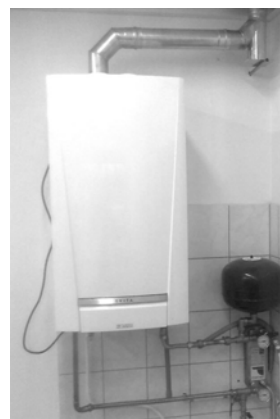
Rys. 4. Model silnika Stirlinga eVita znajdujący się w Instytucie Elektrotechniki i Elektrotechnologii Politechniki Lubelskiej
