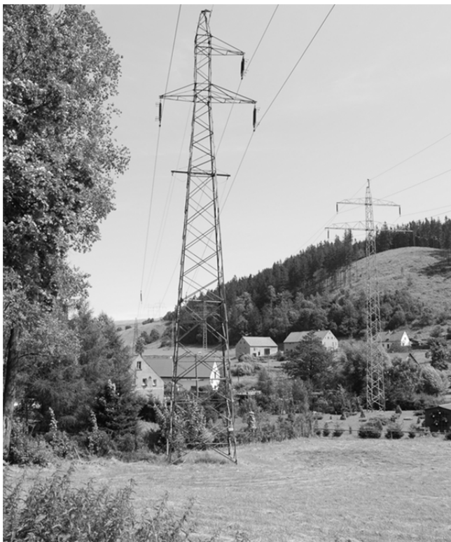
Rys. 1. Jedna z wielu linii elektroenergetycznych 110 kV usytuowanych w pobliżu osad ludzkich
