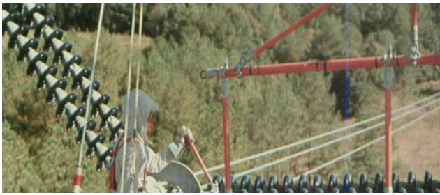
Rys. 5. Elektromonter wykonujący PPN metodą „na potencjale”, na linii 765 kV [12]; na metalizowanym kombinezonie widać liczne faldy i załamania
