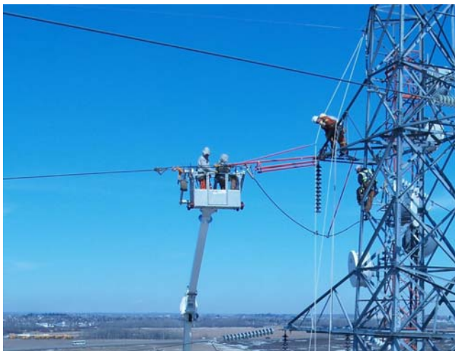
Rys. 6. PPN metodą „na potencjale” (na stupie linii 500 kV), prowadzona z izolowanej platformy, umieszczonej na podnośniku ( www.livelinesolutions.com )
