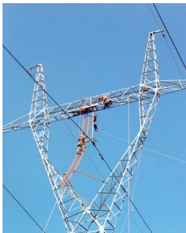
Rys. 1. Wymiana izolatora na słupie przelotowym linii 220 kV [5]
