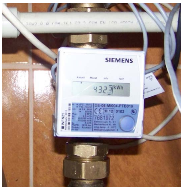
Fig.3. Installed components (Šrámek, 2012)
