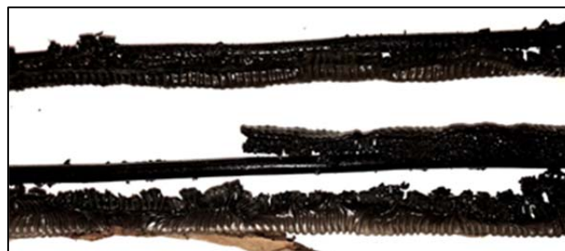
Rys. 6. Zniszczony przewodu elektrycznego H05RR-F po wykonanych badaniach
