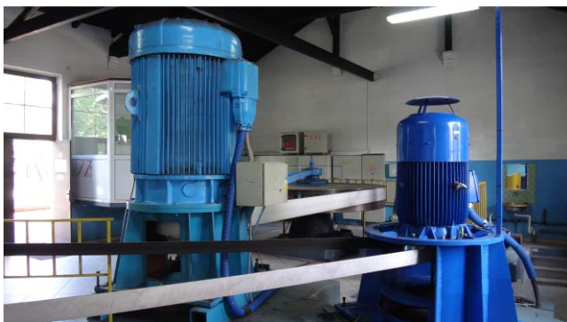
Rys. 3. Przykład małej elektrowni wodnej, w której maszyna asynchroniczna (indukcyjna) jest napędzana turbiną wodną poprzez przekładnię pasową
