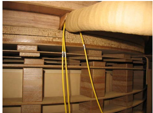
Foto. 4. Część aktywna transformatora blokowego z widocznymi wyprowadzeniami światłowodów.
