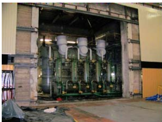
Foto.1. Stary transformator blokowy
