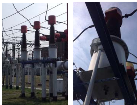
Rys.1. Widok ogólny badanych przekładników typu J110-4a
