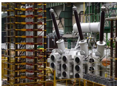
Rys.2. Transformator blokowy typu TOBNRLb 450 000/420
