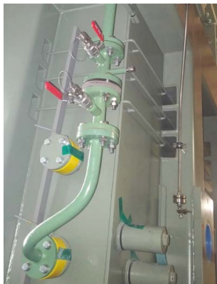
Rys.18. Zawory jednokierunkowe
