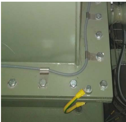
Rys.20. Prowadzenie kabla LHD na kołnierzu kadzi.
