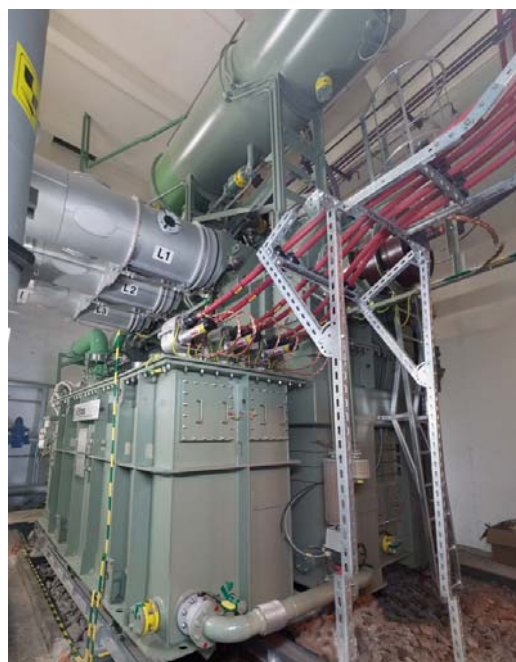
Rys.22. Widok zespołu transformatorów 156 i 6 MVA w komorze.
