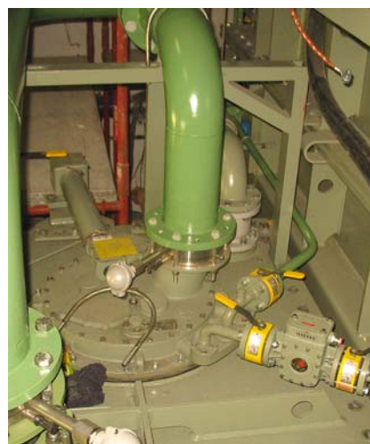
Rys.14. Zestaw rozprężający przełącznika.
