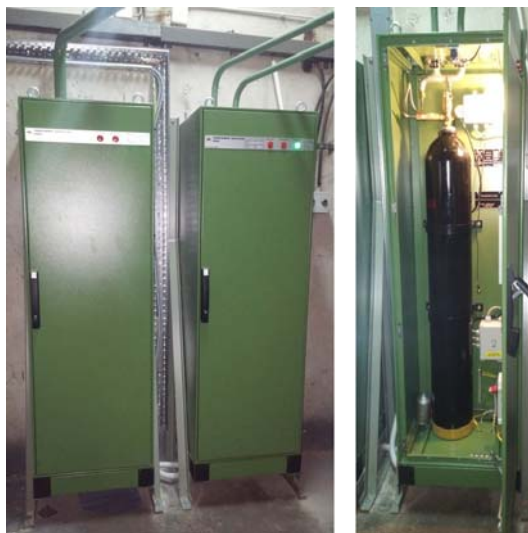
Rys.16. Zainstalowane szafki TP (widok zewnętrzny i wewnętrzny).
