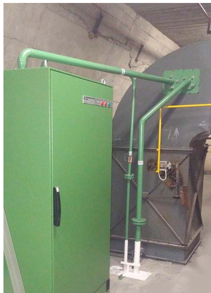
Rys.17. Wyprowadzenie gazów do rurociągu wentylacji.
