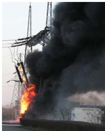
Rys.2. Pożar transformatora na stanowisku
