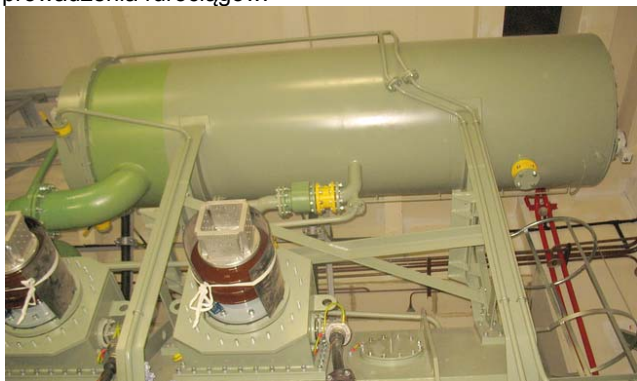
Rys.15. Konserwator z komorą rozdzielania gazu i oleju.
