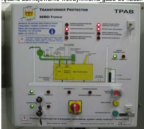
Rys.21. Skrzynka kontrolna zespołu transformatorów.
