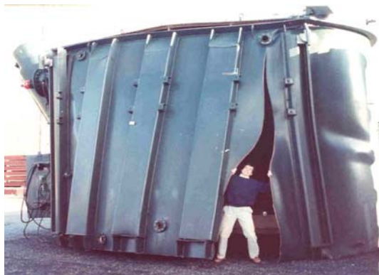
Rys.1. Uszkodzona kadź transformatora [1]
