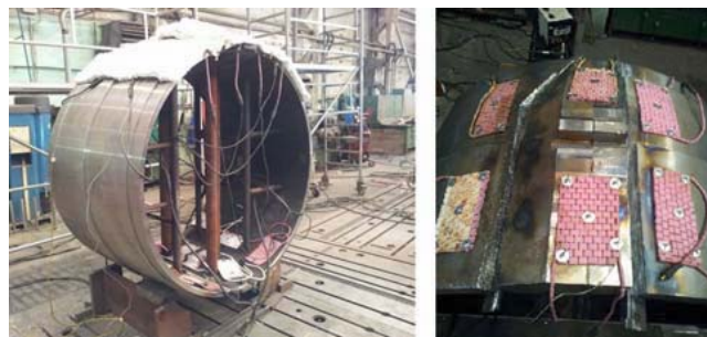
Rys.3 Rozmieszczenie i mocowanie grzałek na zewnątrz konstrukcji w trakcie spawania kołnierzy podziałowych.
