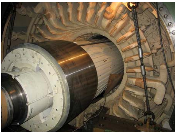
Rys.1. Widok turbogeneratora o mocy 210MW w czasie demontażu wirnika ze stojana, z widocznym kołpakiem
