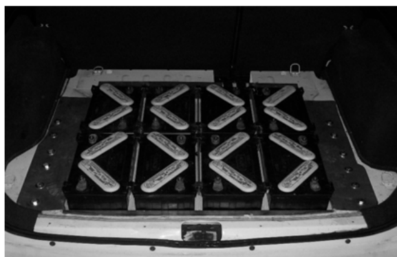
Rys.2. Rozmieszczenie akumulatorów w przedziale bagażowym
