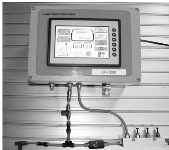
Rys. 5. Widok urządzenia pomiarowego LT-I 200 podczas jego testowania w instalacji sprężonego powietrza
