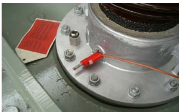
Rys.15. Widok połączenia jednostki pomiarowej z gniazdem pomiarowym przepustu, wg [11]
