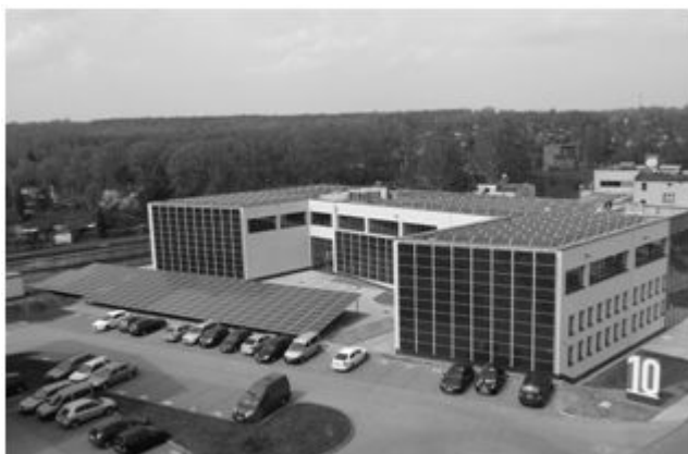
Rys.5. Widok budynku nr 10 w PNT Euro-Centrum Katowice
