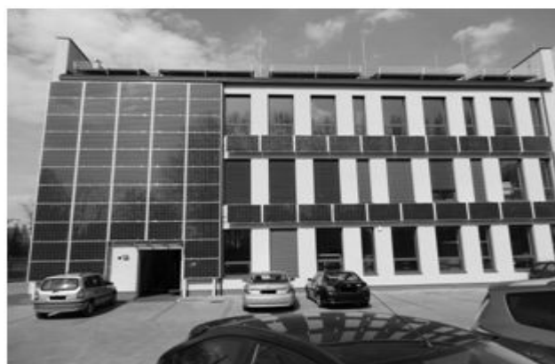
Rys.7. Widok budynku nr 11 w PNT Euro-Centrum Katowice
