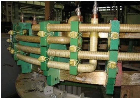
Rys.23. Widok elementów zawieszenia połączeń czołowych z zamontowanymi szynami prądowymi, przed montażem w stojanie
