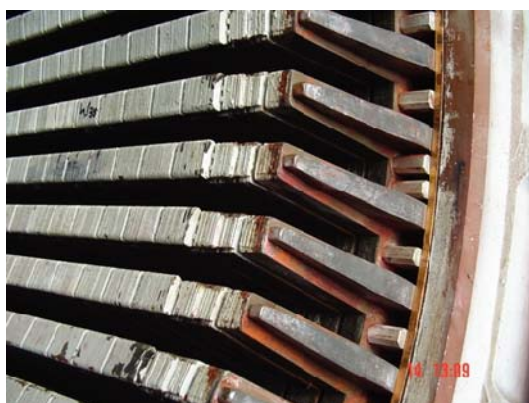
Rys.26. Widok pakietów skrajnych rdzenia stojana po demontażu uzwojenia (turbogenerator TWW-200-2A)
