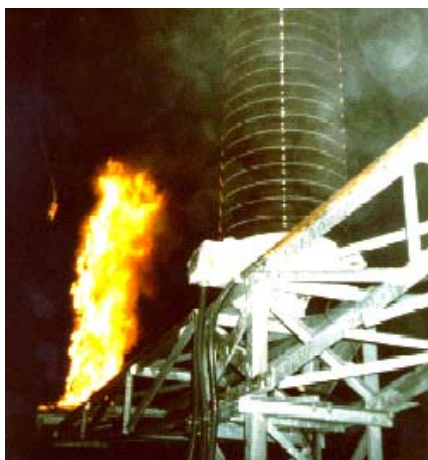
Rys. 3. Destrukcja przekładnika napięciowego 230 kV wskutek ferorezonansu trwającego 12 minut (wg [6])
