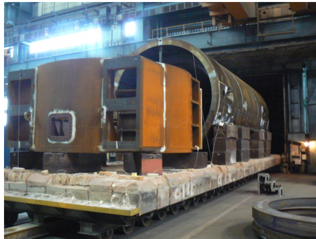
Rys.5. Przygotowanie do wyżarzania odprężającego po spawaniu
