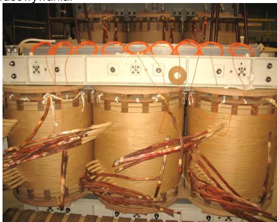
Rys. 12. Zestaw światłowodów zainstalowanych w transformatorze
