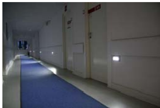
Rys. 2. Widok korytarza z zamontowanymi oprawami ORILED 760 firmy ZUMTOBEL
