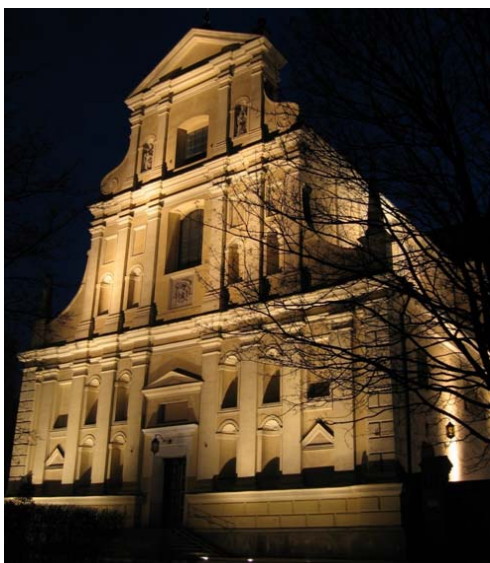
Rys.6. Iluminacja frontowej elewacji kościoła św. Józefa, stanowiącej tło pomnika św. Rafała Kalinowskiego
