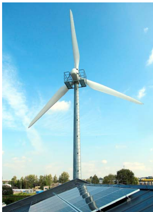
Rys.1. Eksperymentalna elektrownia wiatrowa o mocy 40kW. Elektrownia małej mocy
