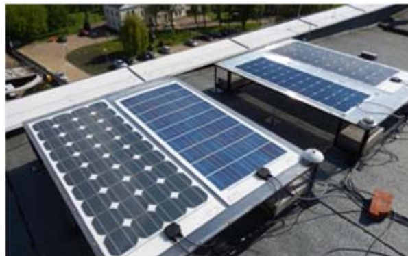
Rys. 3. Panele fotowoltaiczne z czujnikiem nasłonecznienia na dachu budynku Wydziału Mechanicznego Politechniki Lubelskiej
