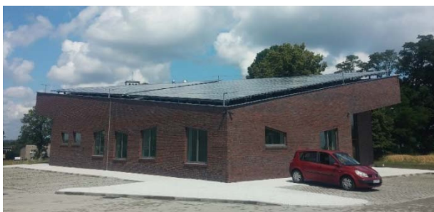
Rys. 3. Budynek przychodni w Pryszowicach ze 126 panelami fotowoltaicznymi o mocy 260 kW
