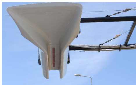
Rys. 5 a) E-bus wyposażony w system szybkiego ładowania b) gniazdo stacjonarnej ładowarki
