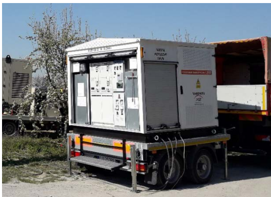
Fot.1. Mobilna stacja transformatorowa z synchronizacją 15 kV PGE Dystrybucja 2019
