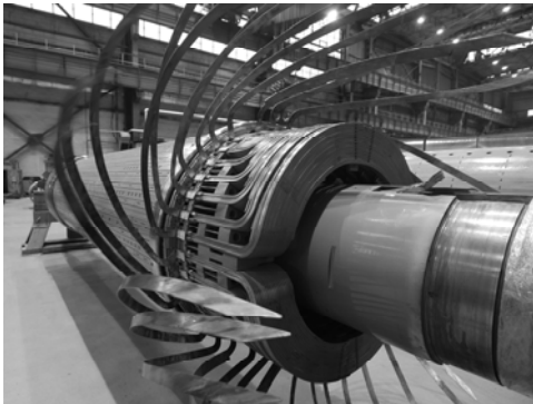
Rys. 8. Wirnik zmodernizowanego generatora po zdjęciu kołpaków
