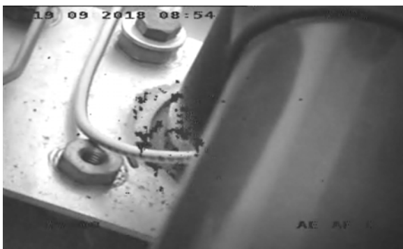
Fot.3. Wyładowania koronowe na moście SN, (fot. Durak S., Gustaw M.)
