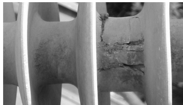
Fot.5. Uszkodzenie na powierzchni izolatora [13]
