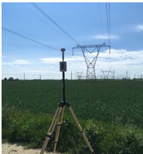
Rys.1. Miejsce przeprowadzenia badań terenowych obok stacji elektroenergetycznej w Pasikurowicach, woj. dolnośląskie
