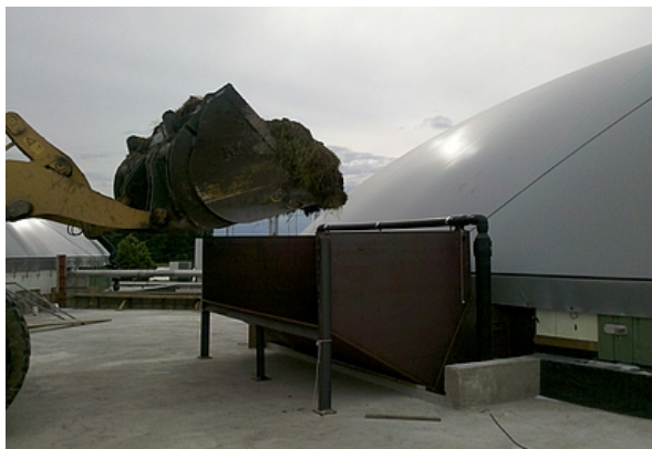
Rys.5. Kanał załadawczy komory fermentacyjnej z systemem zraszającym
