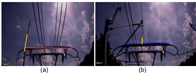
Rys. 8. Przykładowe błędy w działaniu oprogramowania: a) wykrycie słupa zamiast przewodu jezdniego, b) wykrycie wieszaka sieci przewodu jezdniego
