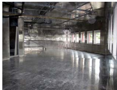
Rys. 4. Pomieszczenie badawcze ekranowane systemem Systron PowerShield® produkcji firmy SYSTRON Magnetic Shielding w technologii blach warstwowych [10]
