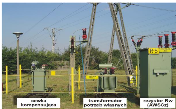
Rys.10. Zespół urządzeń do kompensacji ziemnozwarciowej
